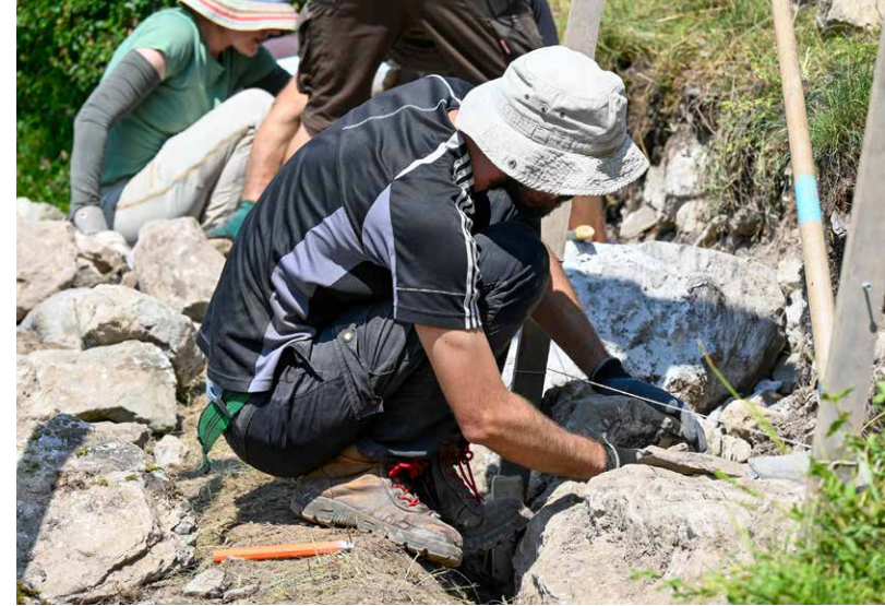
Trockenmauer-Baukurs 2024 in Lantsch / Lenz Stavels
